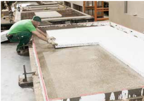
Recouvrir la peau de parement fraîchement bétonnée par des panneaux d'isolant.
