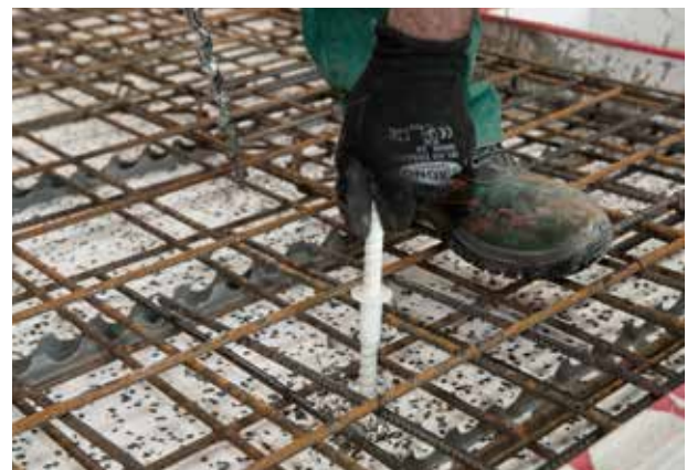
Insérer Schöck Isolink® type C-SH dans la couche d'isolant pré-percé.
