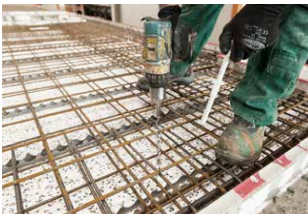
Pré-percer des trous dans l'isolant.
