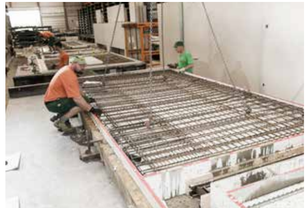
Mise en place de l'armature de la peau intérieure.
