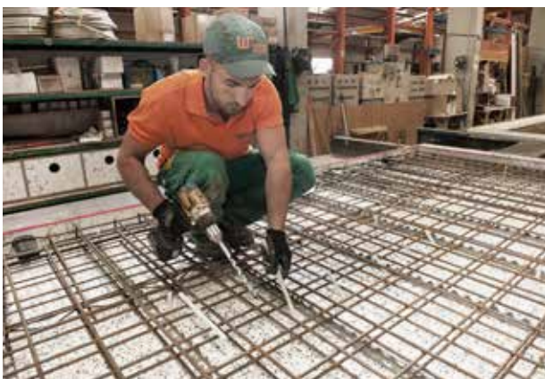
Si nécessaire, utiliser des barres diagonales (Schöck Isolink® type C-SD).
