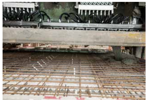
Bétonnage de la peau intérieure.
