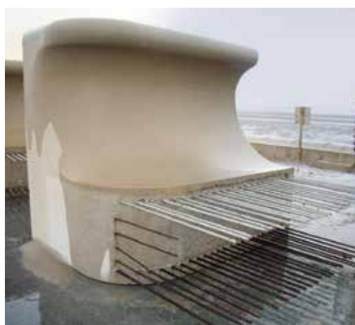
Éléments préfabriqués le long du quai à Blackpool en Grande-Bretagne.
