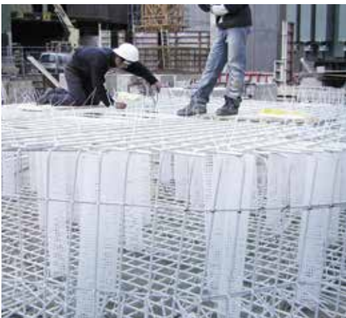
Fondations des transformateurs de la Peiner Träger GmbH à Peine en Allemagne.
