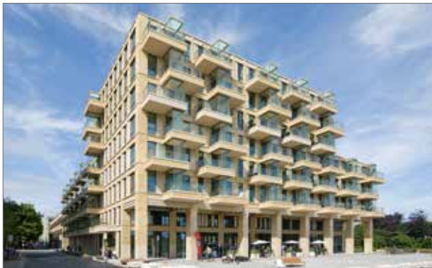
Balkons project Square Amsterdam achteraf gemonteerd met Schöck IDock®
