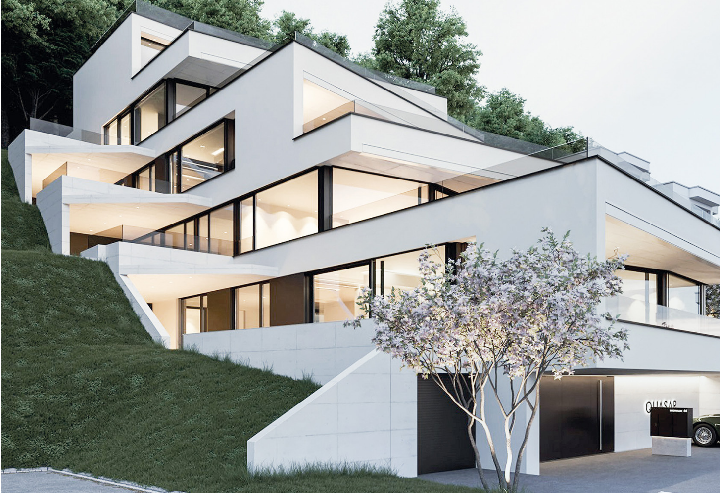
Budynek mieszkalny "Quasar", Erlinsbach, (CH)
