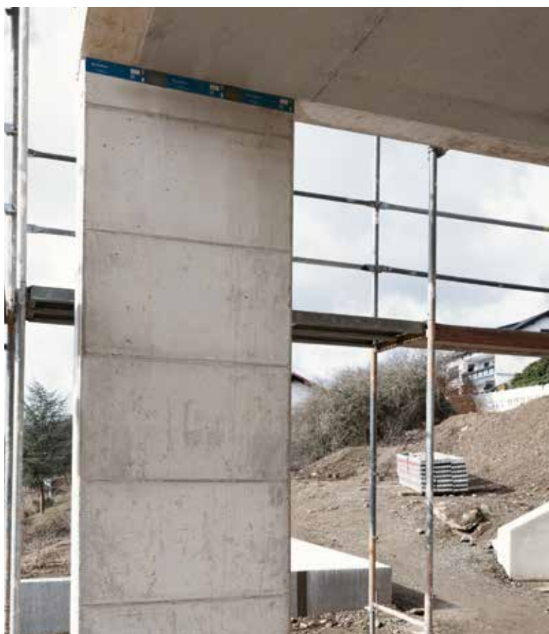
Sconnex® permet de créer des profils muraux minces avec une finition apparente en béton et d'éviter définitivement les ponts thermiques.
