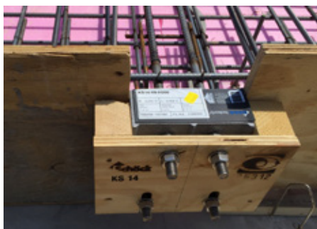
Abb. 1: Isokorb® ausrichten und fixieren mittels Einbauschablone
