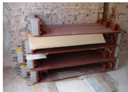
Abb. 2: Einbauteile mit Isokorb® T Typ S
