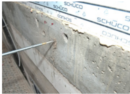
Abb. 1: Bohrungen in Decke herstellen und reinigen
