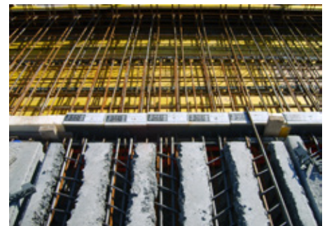
Abb. 2: Oberseitige Vergusstaschen in den Hohlkörperdecken mit Übergreifungsstößen
