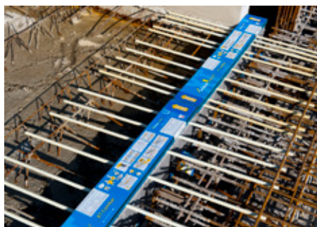
Abb. 1: Isokorb® in Bewehrung einsetzen
