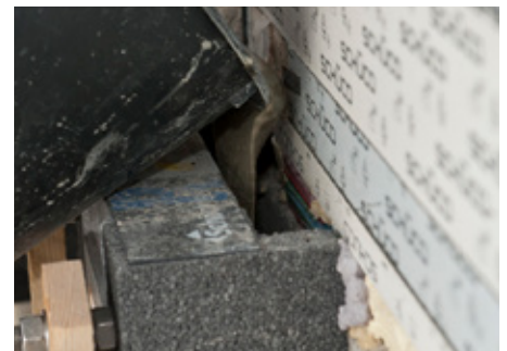
Abb. 2: Isokorb® einkleben und Vergusstasche kraftschlüssig verfüllen
