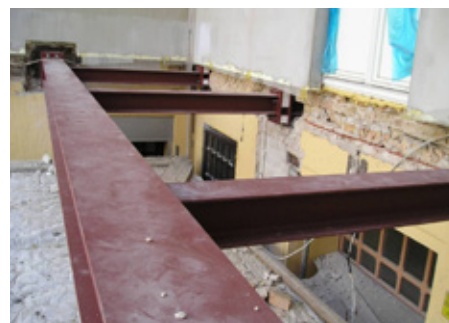
Abb. 2: Thermisch getrenntes Tragwerk des neuen Balkons
