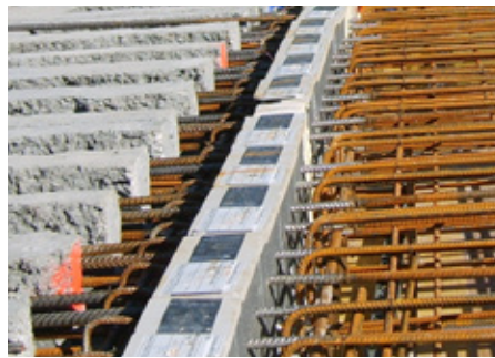
Abb.1: In Bewehrung eingebauter Isokorb®
