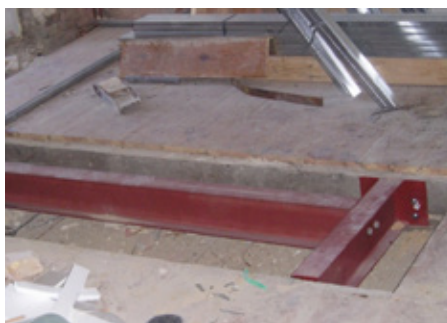
Abb. 1: Rückverankerung des Balkons in die Holzbalkendecke
