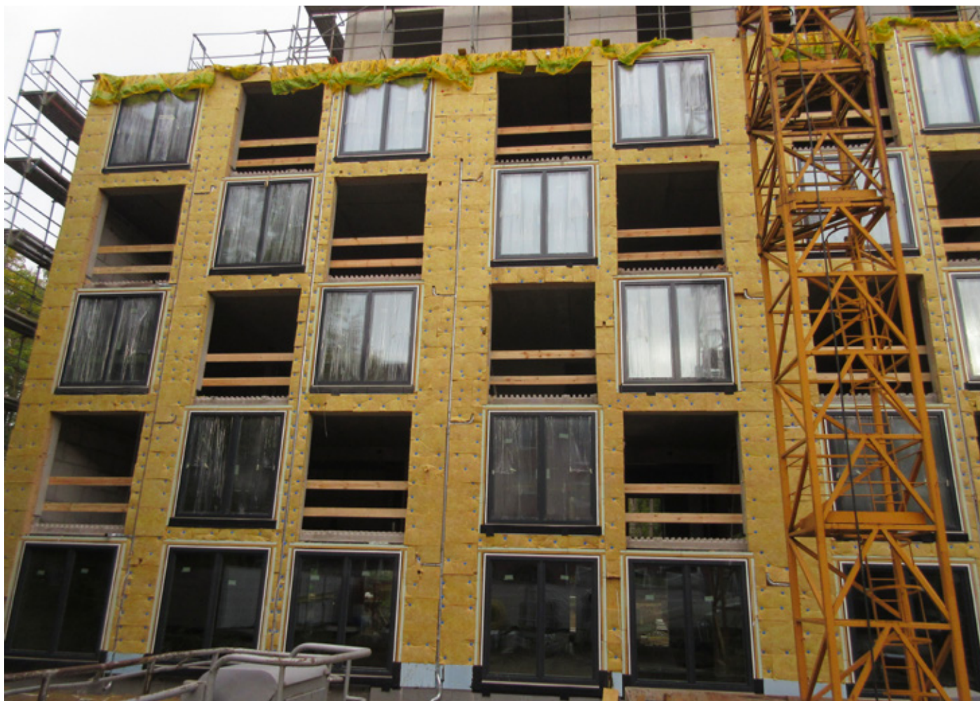
Abb. 3: Rohbau fertigstellen
