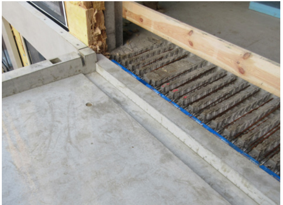
Abb. 5: Aussparungen mit Vergussmörtel verfüllen, 48 Stunden aushärten lassen
