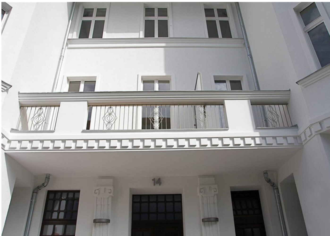
Abb. 3: Denkmalgerecht sanierter und thermisch getrennter Balkon
