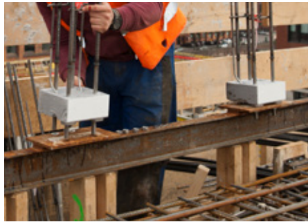
Abb. 1: Isokorb® auf Stahlschablone fixieren
