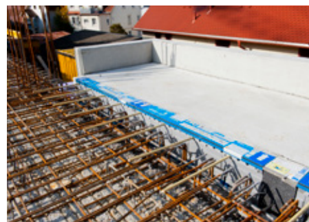
Abb. 2: Einbau in Decke, Abstützen des Fertigteils
