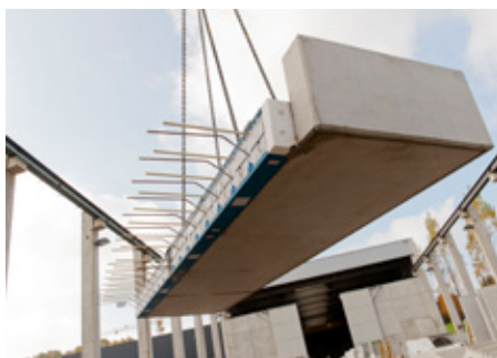
Abb. 1: Anlieferung des Fertigteils auf die Baustelle
