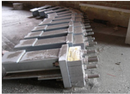
Abb. 1: neuer Balkonanschluss mit Isokorb® T Typ S
