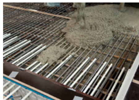
Abb.2: Decke und Balkonplatte betonieren
