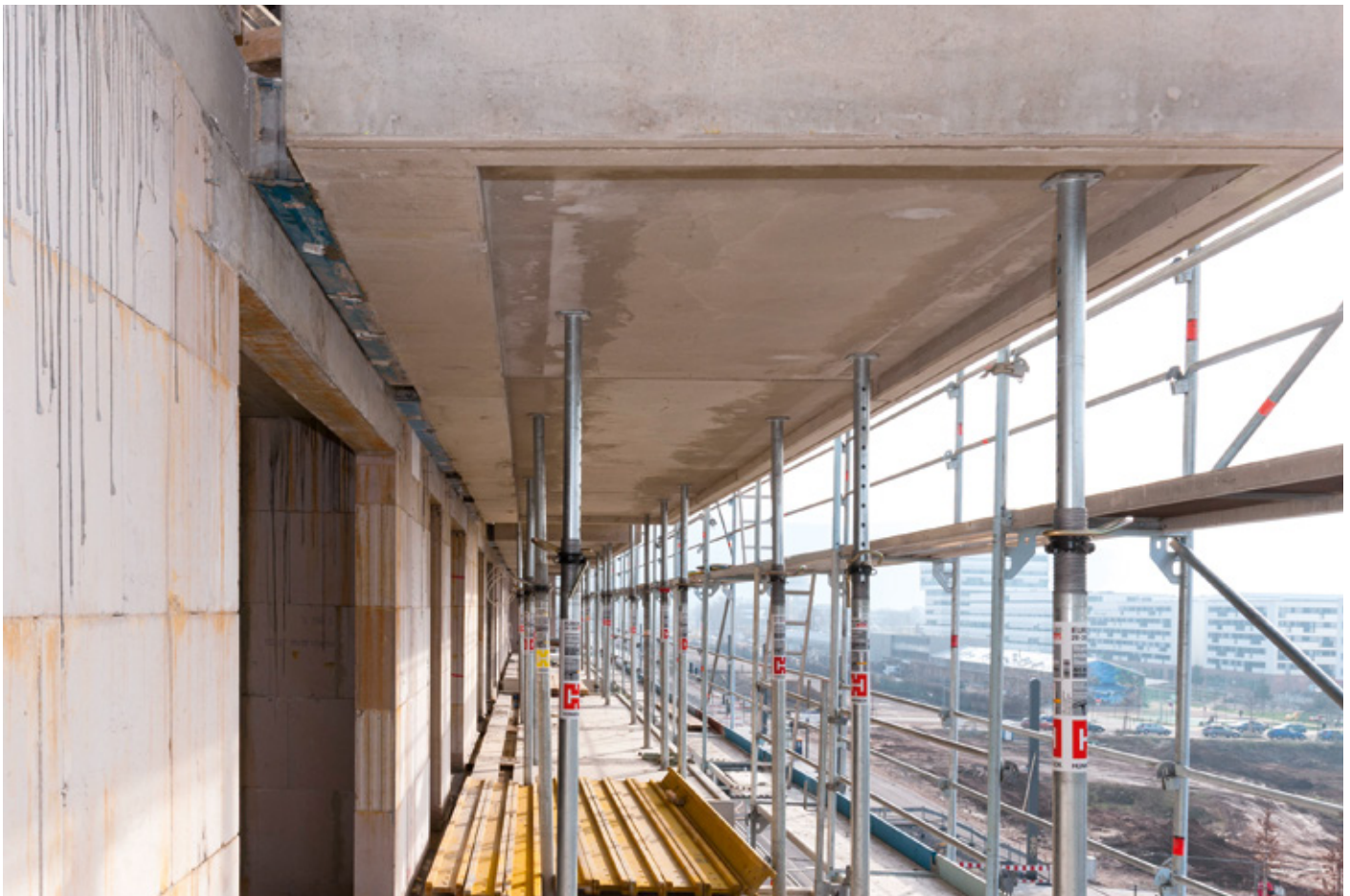
Abb. 3: Balkonplatten bis zur Endfestigkeit abstützen
