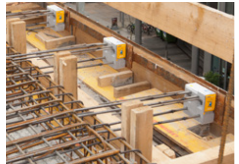
Abb. 2: in Deckenbewehrung einschieben, Stahlschablone gewährleistet den exakten Einbau
