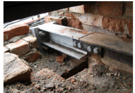
Abb. 2: neuer Balkonanschluss an bestehendem Stahlträger
