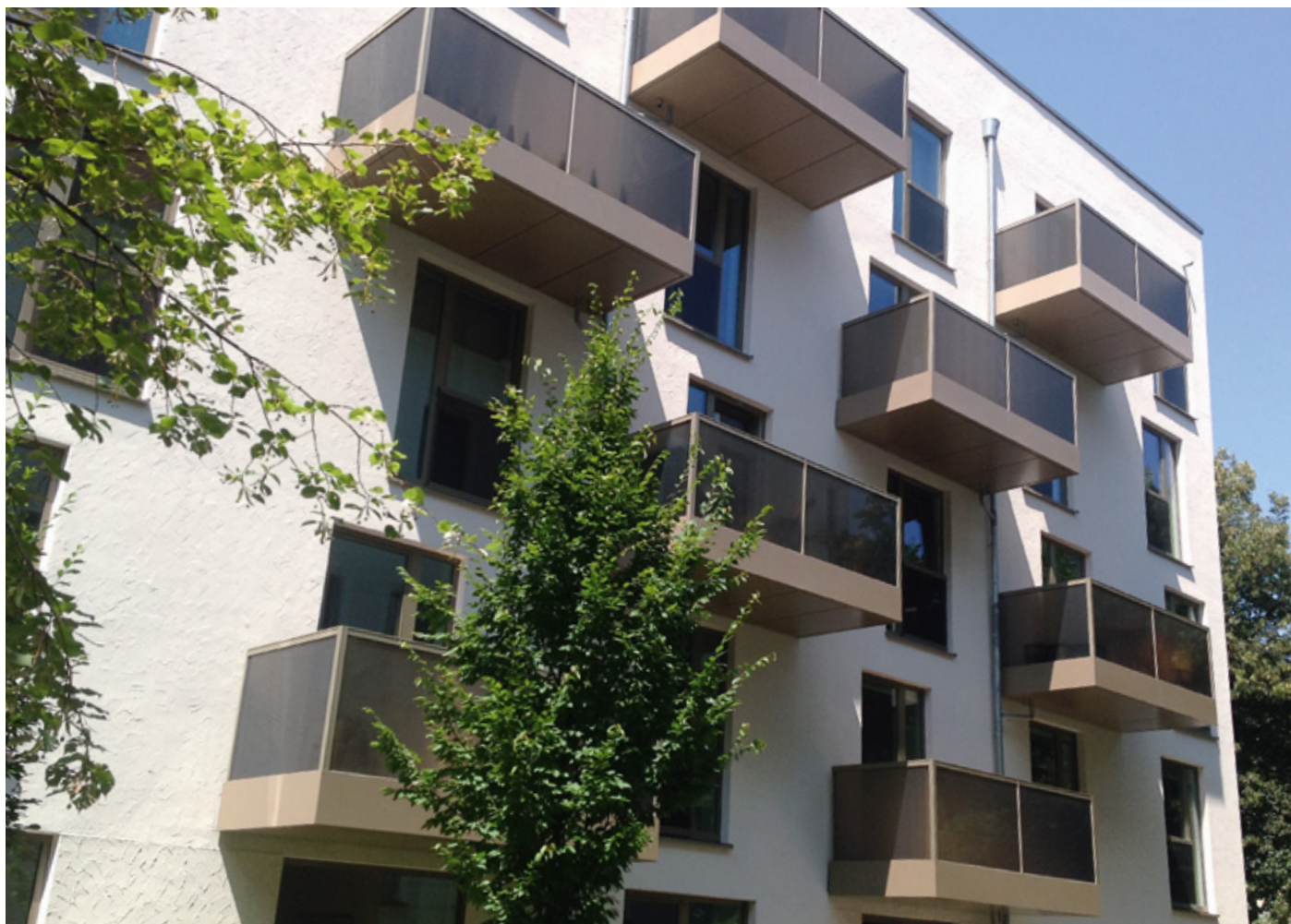
Abb. 3: Sanierungsobjekt mit thermisch getrennten Balkonen
