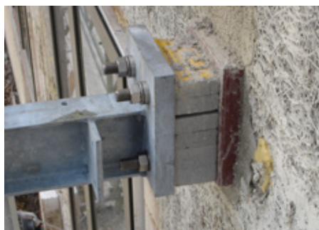
Abb. 1: Neuer Balkonanschluss mit Isokorb® T Typ S
