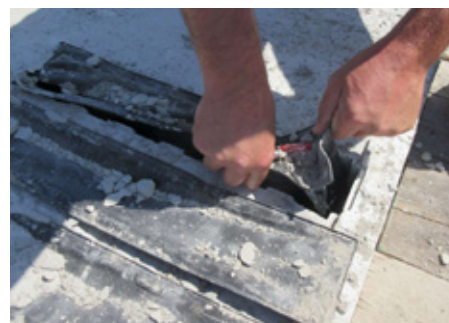
Abb.2: Decken- und Randelemente nach dem Aushärten entfernen
