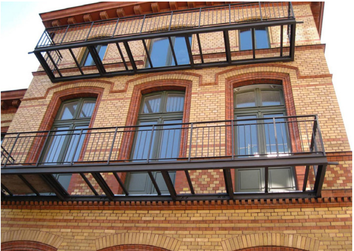
Abb. 3: Thermisch getrennter Stahlbalkon an historischer Fassade
