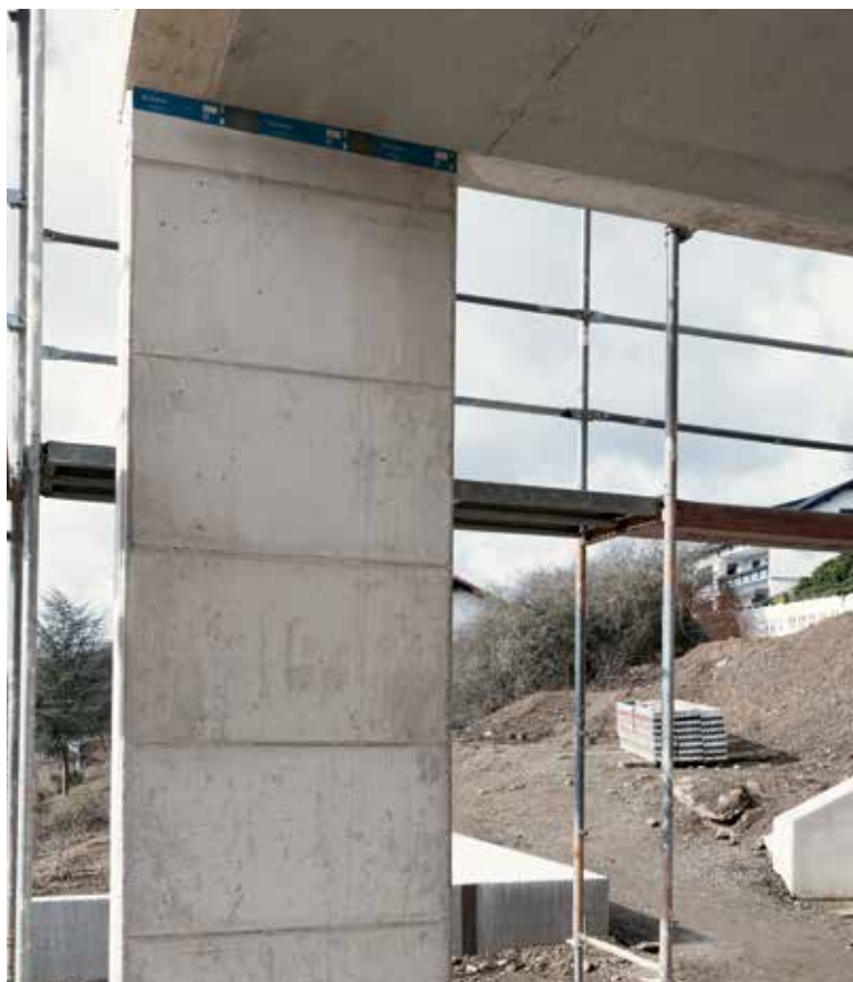
Sconnex® umožňuje tenké stěny z pohledového betonu s trvale vyřešeným tepelným mostem.
