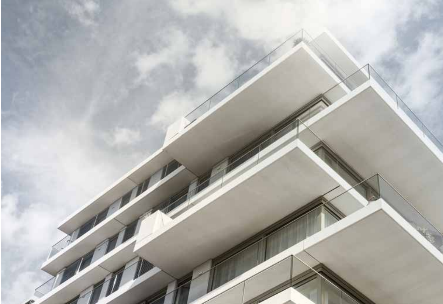
Coolhouse, Nizozemska. Foto: Luuk Kramer fotografie
