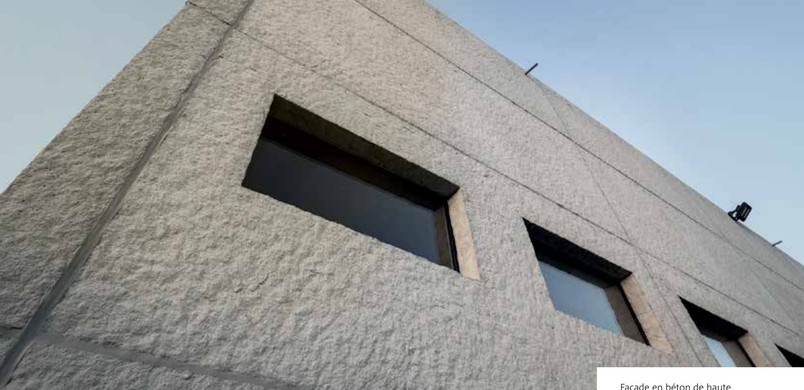
Façade en béton de haute qualité à l'aspect de pierre naturelle du hall industriel de Marcus Riedelsheimer GmbH
