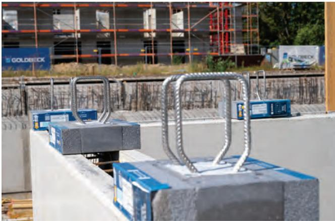
**Bild 2** Schöck Sconnex® Typ W reduziert Wärmebrücken an Stahlbetonwänden und erhöht die Energieeffizienz des gesamten Gebäudes.
