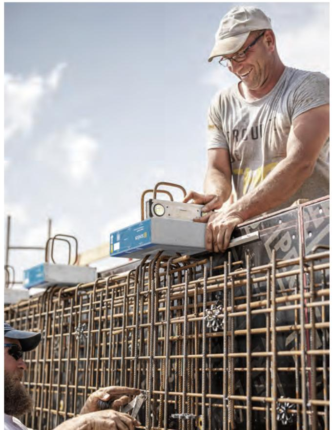
**Bild 1** Thermisch Trennen statt Einpacken: Das Wärmedämmelement Schöck Sconnex® Typ W ermöglicht auch schlanke Stahlbetonwände in attraktiver Sichtbeton-Ästhetik.
