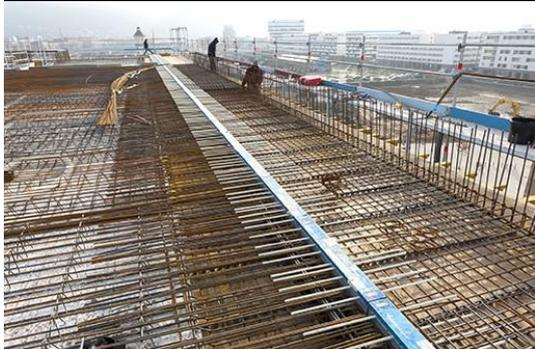
*Auf der Baustelle wurden die Fertigteile inklusive Isokorb mit der Decke vergossen. Foto: Schöck Bauteile GmbH*
