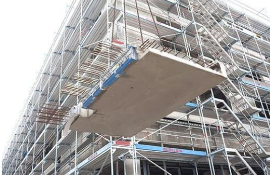
*Um eine gute Sichtbetonqualität zu erhalten, wurden die Balkone im Fertigteilwerk gefertigt; das tragende Wärmedämmelement Schöck Isokorb CXT wurde in die Schalung gelegt und eingebaut. Foto: Schöck Bauteile GmbH*
