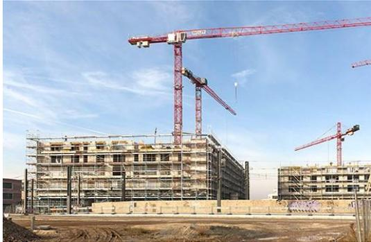
*Markantes Merkmal der drei Gebäude der Westarkaden sind unter anderem die geometrisch unterschiedlich gestalteten Balkone, von denen einige eine Länge von bis zu 21 m aufweisen. Foto: Schöck Bauteile GmbH*
