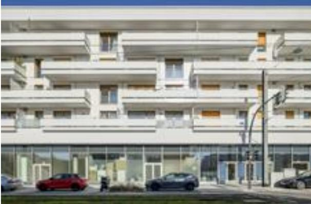
*Im Bauteil 1 der Westarkaden Heidelberg wurden fugenlose Balkonteile in unterschiedlicher Länge gestaltet. Foto: Moritz Bernouilly*
