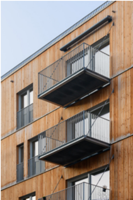
Die Fassade zum Hof ist aus Gründen der Haltbarkeit mit unbehandeltem Lärchenholz bekleidet. Foto: Moritz Bernouilly
