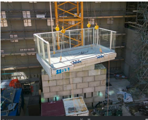
*Die neue Generation des tragenden Wärmedämmelements für den Balkonanschluss, Schöck Isokorb IQ, schafft zusätzliche Potenziale für das bauzeitenflexible Bauen mit einem hohen Vorfertigungsgrad. Isokorb IQ ermöglicht es erstmals, thermisch getrennte Fertigteilbalkone nachträglich an ein Neubauobjekt anzuschließen. Im Bild: Fertigteilbalkon mit Isokorb IQ beim Projekt „One MilkyWay“, Den Haag / NL*
