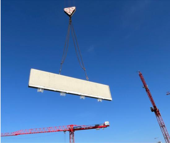
*Effizient Bauen bedeutet bauzeitenflexibel: Schöck TELLIGENT bietet Produktlösungen, die einen hohen Vorfertigungsgrad der Bauteile ermöglichen und damit just-in-time auf die Baustelle geliefert werden können. Im Bild: Ein Brüstungselement für die Attika mit Schöck Isokorb CXT Typ A wird per Kran eingehoben.*
