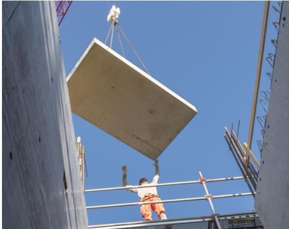
*Auch bei Treppen kann der Bauablauf mit effizienten Lösungen und Bauteilen deutlich beschleunigt werden. Im Bild: Ein mit dem Trittschalldämmelement Schöck Tronsole vorgefertigtes Treppenpodest wird in Rekordzeit in das bestehende Gebäude eingehoben und schallisoliert fixiert.*
