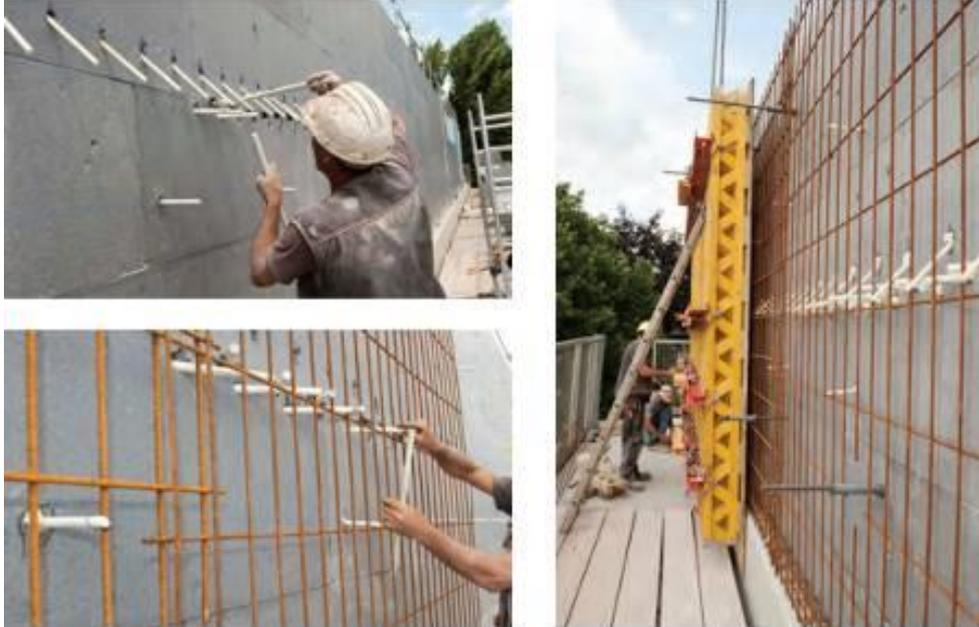
*Auf die tragende Wand aus Ortbeton wurden die Dämmplatten aufgeklebt und Bohrlöcher für insgesamt 920 Schöck Thermoanker gesetzt. Anschließend wurde die Beton-Außenschale vor Ort angegossen. Dank der geringen Wärmeleitfähigkeit der Glasfaserbewehrung erzielt die kerngedämmte Sandwichwand bei einer Gesamtdicke von 44 Zentimeter einen U-Wert von nur 0,323 W/m<sup>2</sup>K. Foto: Schöck Bauteile GmbH, Abdruck honorarfrei.*
