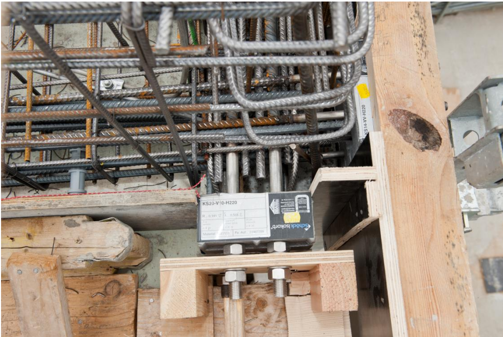
[Isokorb Typ KS eingebaut.jpg]
