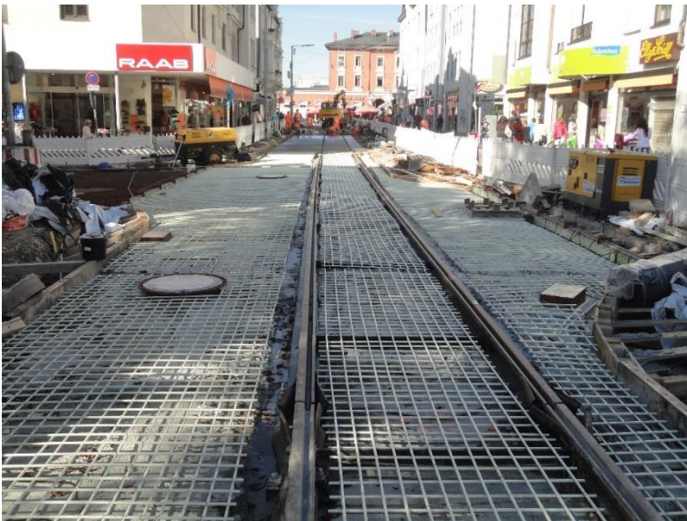
Oberflächenbewehrung mit Combar, München-Pasing. Foto: Schöck Bauteile GmbH, Abdruck honorarfrei.
