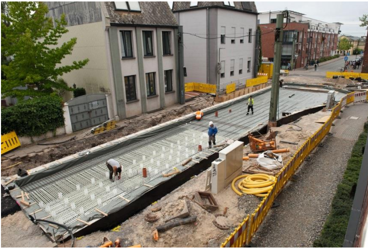
Leichtes Masse-Feder-System mit Combar am Gleisdreieck Bielefeld. Foto: Schöck Bauteile GmbH, Abdruck honorarfrei.
