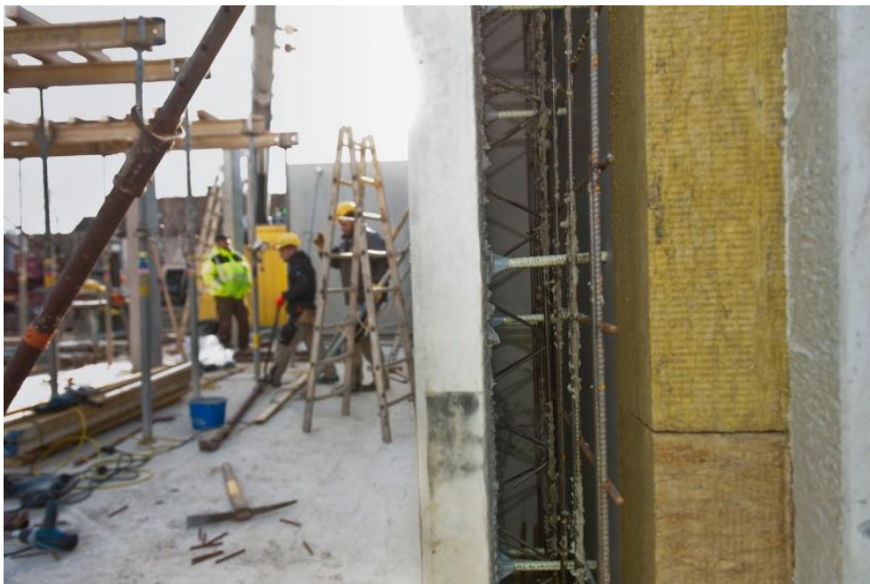
Durch den Schöck Isolink werden bei kerngedämmten Betonwänden Wärmebrücken vermieden. Foto: Schöck Bauteile GmbH, Abdruck honorarfrei.
