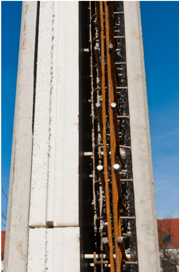
Aufbau einer Elementwand. Der Schöck Isolink verbindet alle Schichten: Vorsatzschale, Dämmschicht, Ortbeton-Tragschicht und Betonfertigteile. Foto: Schöck Bauteile GmbH, Abdruck honorarfrei.
