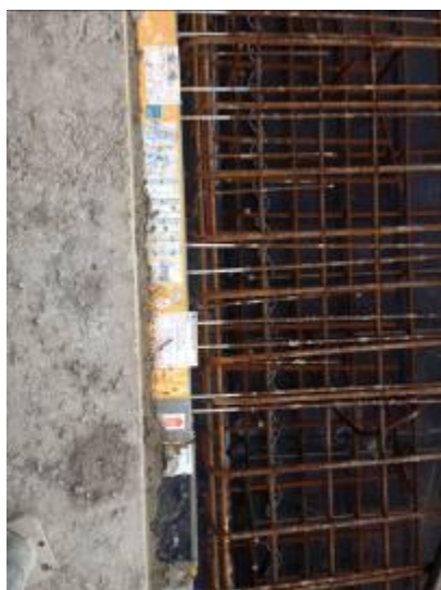
Schöck Isokorb Żelbet/Żelbet do balkonów wspornikowych Fot. Schöck
