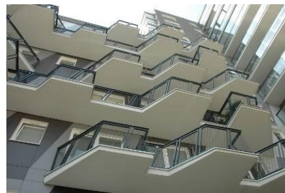
Dzięki wykorzystaniu łącznika termoizolacyjnego Isokorb typu K możliwe było swobodne kształtowanie geometrii balkonu w obiekcie Kamion Cross Fot. Schöck
