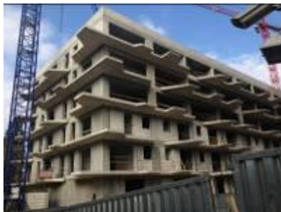
Balkony Kamion Cross w trakcie budowy Fot. Schöck
