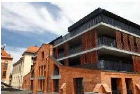
Źródło: Tribeach Holdings LLC./MOSTOSTAL WARSZAWA S.A.
