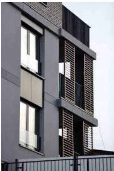
Źródło: Tribeach Holdings LLC./MOSTOSTAL WARSZAWA S.A.
