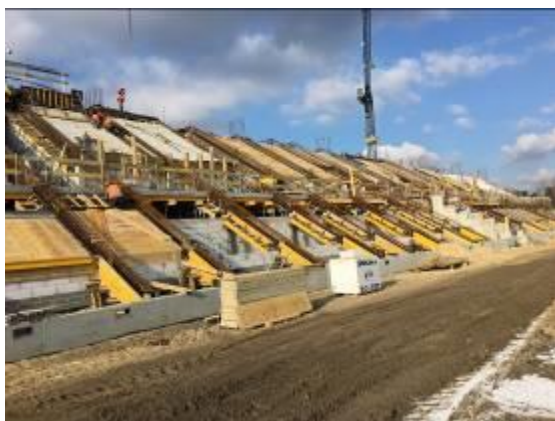
Nowa trybuna stadionu w budowie Fot. Schöck
