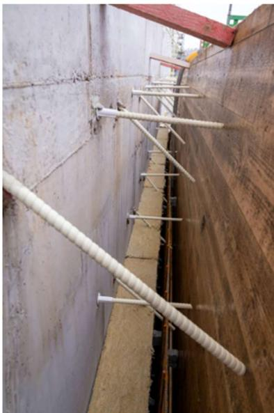
*Deutlich erkennbar: Im oberen Teil die in die Tragschicht eingebohrten Schöck Isolink Typ C sowie die Schalung. Im unteren Teil der Blick von oben auf die Dämmschicht und die Bewehrung. Bild: Schöck*
