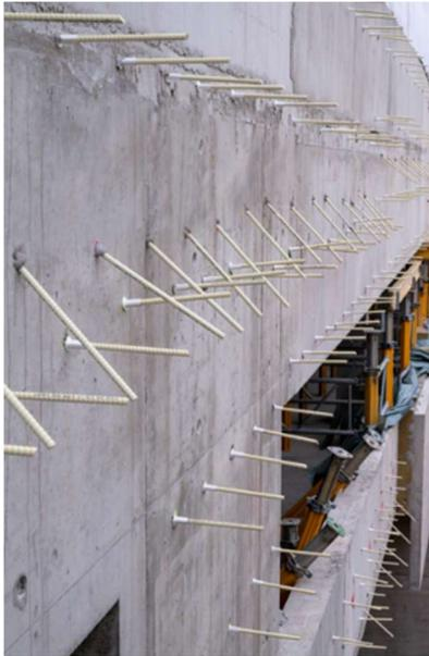
*Die Positionierung der Bohrlöcher entspricht exakt den Vorgaben aus dem Verlegeplan. Bild: Schöck Bauteile GmbH*
