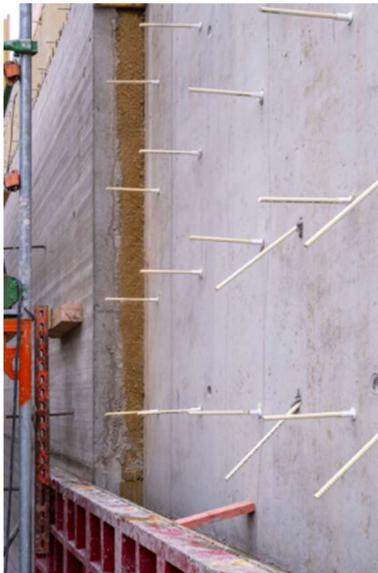
*Links die bereits fertiggestellte Fassade mit deutlich nachvollziehbarem Wandaufbau. In einem weiteren Schritt wird rechts der nächste Abschnitt der Fassade angefügt. Bild: Schöck Bauteile GmbH*
