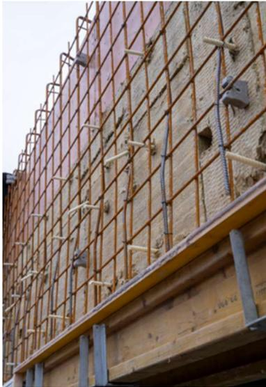
*Die Bewehrung für die Vorsatzschale ist eingebaut. Schöck Isolink Typ C ragt über die Dämmung hinaus und verbindet später den Beton der Vorsatzschale durch die Dämmschicht mit der Tragschale. Bild: Schöck Bauteile GmbH*
