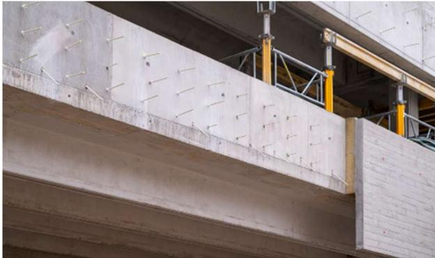
*Die fertige Sichtbetonfläche rechts lässt den wilden Verband klar erkennen. Die Fassade ist durch Schöck Isolink Typ C fest, sicher und wärmebrückenfrei durch die Dämmschicht hindurch mit der Tragschale verbunden. Bild: Schöck Bauteile GmbH*
