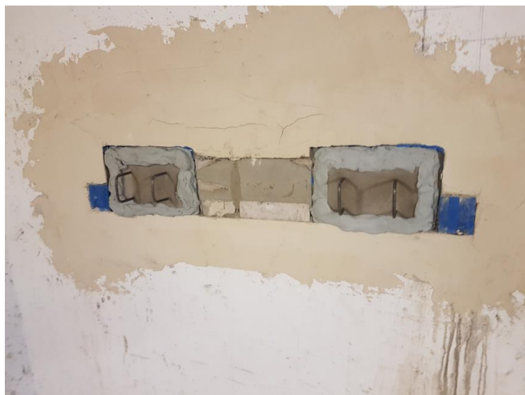
Abbildung 2: Trennwand mit geschlossenen Aussparungen
