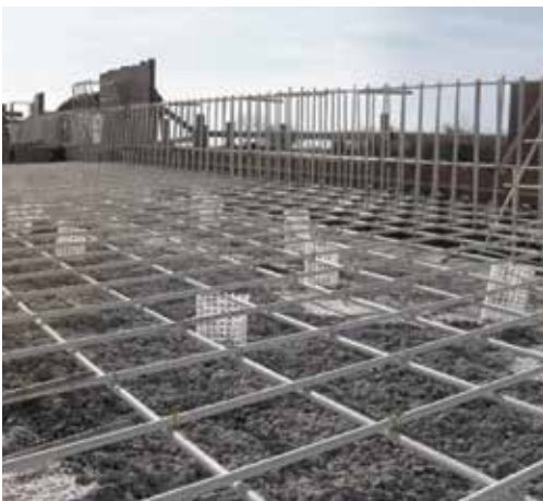
Canal Bridge -sillan rauditus, Kanada
