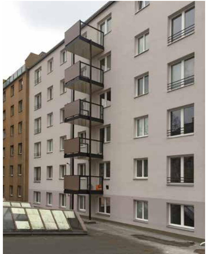
Nachher: Für die Bewohner/innen sind die vor die Fassade gesetzten Balkone in jedem Fall ein Gewinn – aber auch optisch lockern sie die schmucklose Hoffassade auf.
