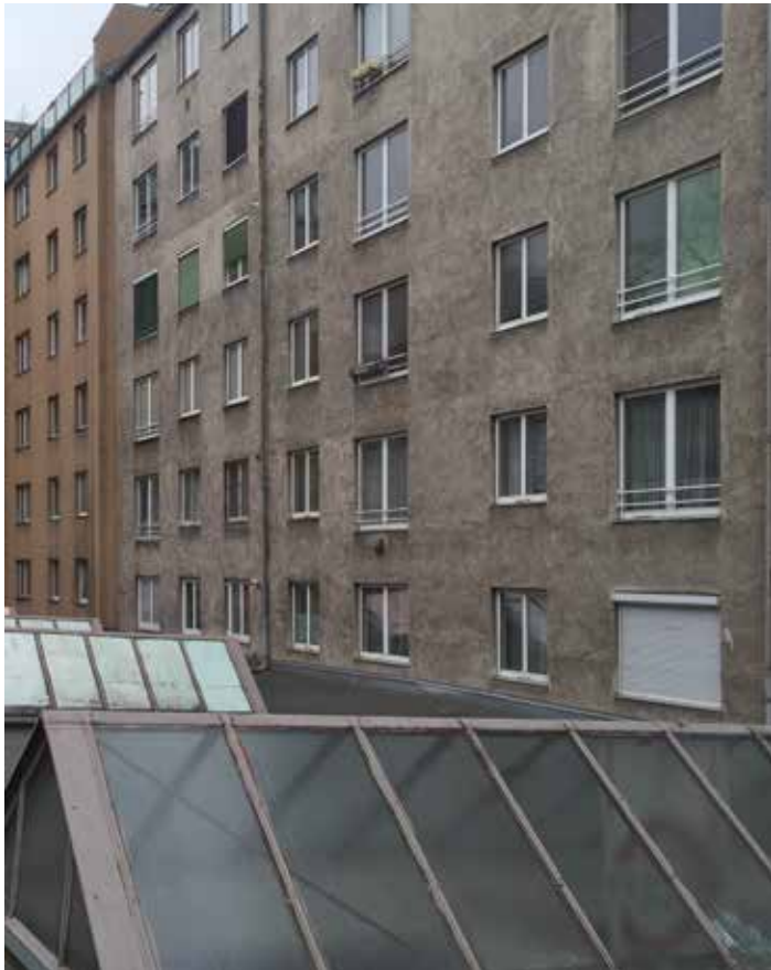
Vorher: Die typische Rückseite eines Wiener Wohnbaus aus den 1960er Jahren – glatte Lochfassade und bis auf den Wechsel in den Fensterformaten kaum Gliederungselemente.
