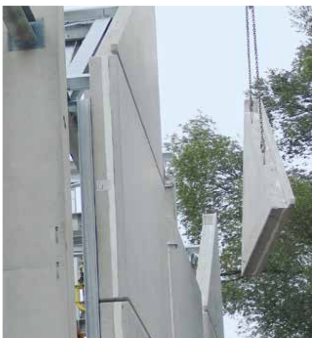
Sendvičová stěna s kotvami Schöck Isolink®
