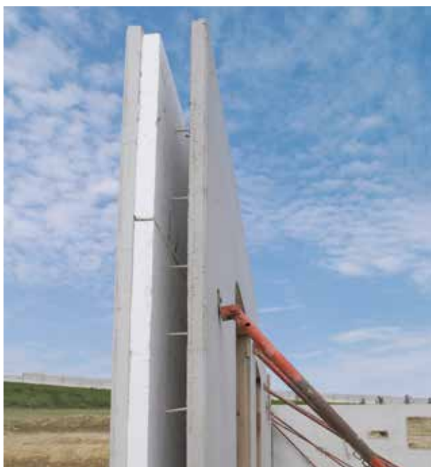
Dvojitá poloprefabrikovaná stěna s kotvami Schöck Isolink®
